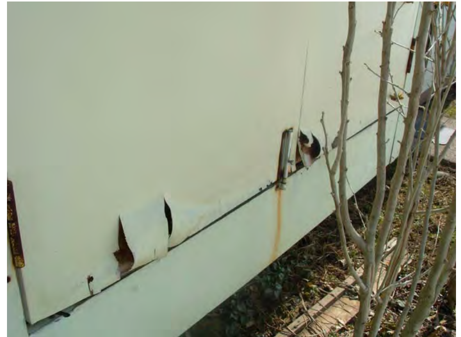
8. Metering closet door deterioration
